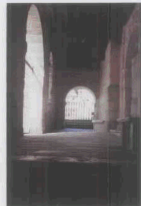
Los escalones que cierran el pórtico corresponden al moderno realzado de la carretera
