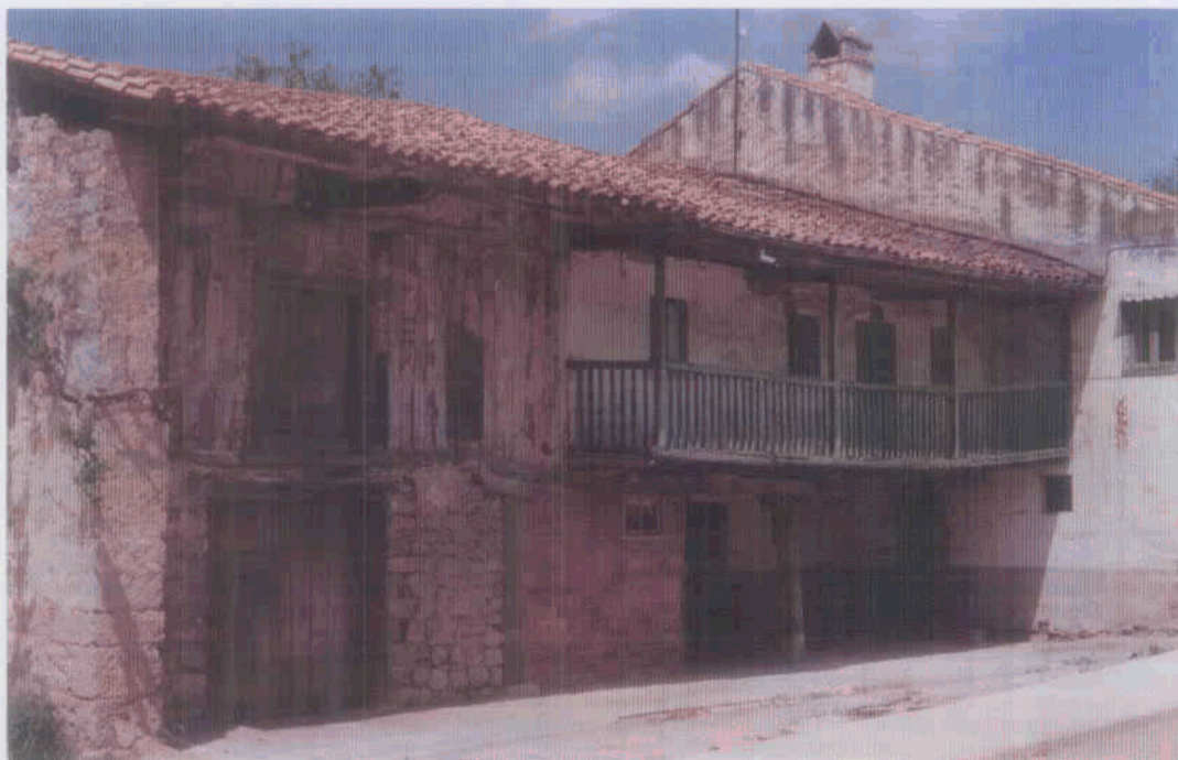
En Mijares, tipo de transición de casa llana con solana, pórtico y cuadra.
