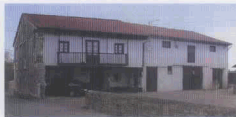
En Quevada, de transición de portico a casa cuadra
